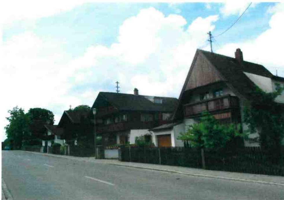
Bebauung an der Pfaffinger Straße (Blick von Südosten)
