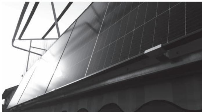
Am häufigsten hängen sie tatsächlich an der Balkonbrüstung. Manch einer stellt ein Modul nur nach Bedarf auf der Terrasse auf, oder es wird unterm Fenster an der Fassade befestigt. Eines haben sie alle gemeinsam, sie haben an der Rückseite einen kleinen Modulwechselrichter mit, im einfachsten Fall, einem Schukostecker als Stromausgang. Sobald dieser in die Steckdose gesteckt wird, beginnt das Kraftwerk Strom zu liefern.
