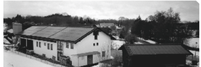
Fertig! Wertstoffhof, Bauhof und Pumphaus März 2006
